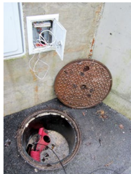
Izvajalci Telekoma Slovenije te dni izvajajo priklope na optično omrežje na območju Sela, Vesce in Utika.
